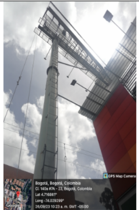
Foto 2. Vista del mástil y de la estructura de la valla en buenas condiciones y estable.
